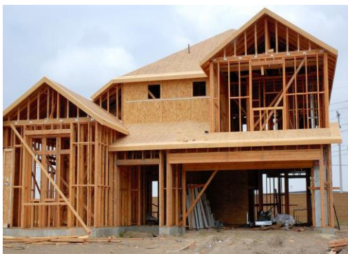
Figura 1: Estrutura de madeira em wood frame.
