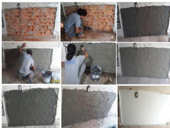
FIGURA 9 – PROCESSO DE APLICAÇÃO DE ARGAMASSA COM O USO DE
