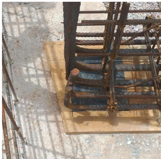
Figura 6 - Instalação Neoprene.
