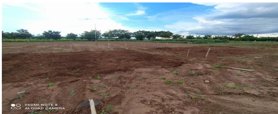
Figura 1. Limpeza do terreno e demarcação das áreas. Jaciara, MT, 2021.
