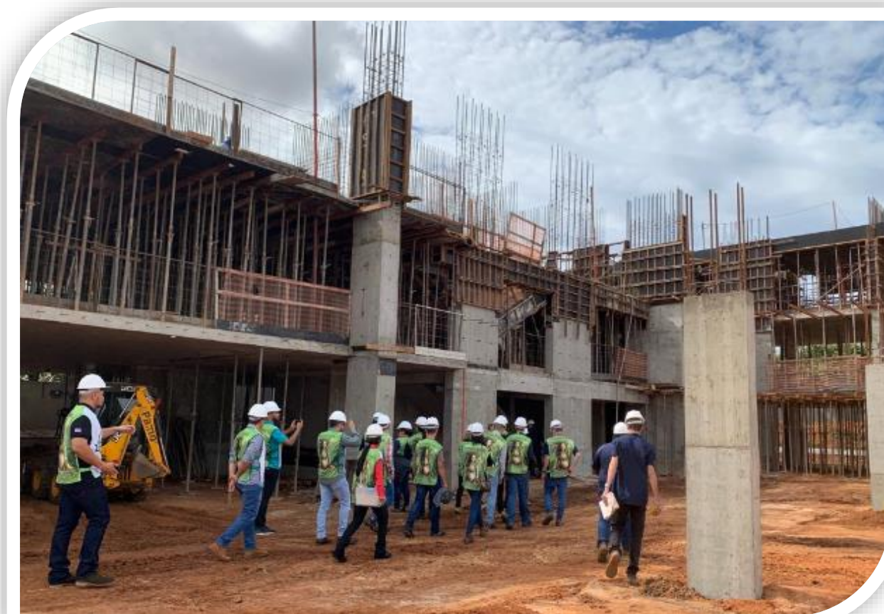
Figura 2: visita dentro do canteiro de obra.
