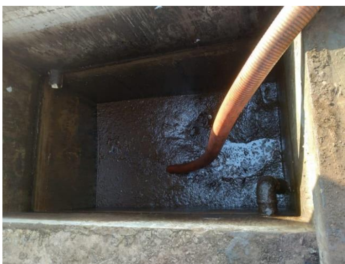
Figura 6 - CSAO após drenagem.
