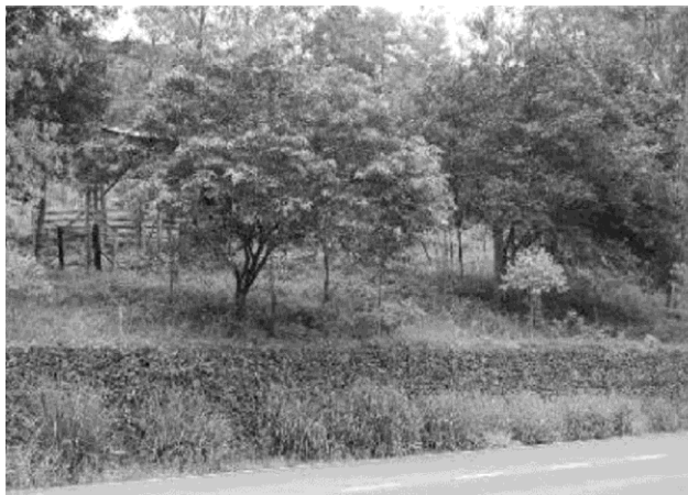
Figura 1 - Técnica de Muro de Gabião
