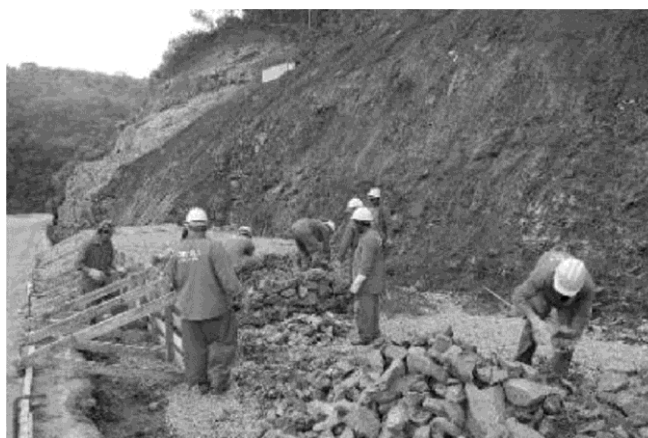
Figura 2 - Técnica de Muro de Gabião
