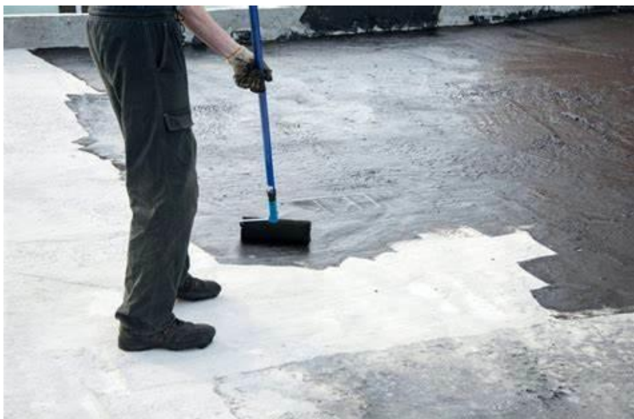
Figura 1- Processo de aplicação da membrana asfáltica
