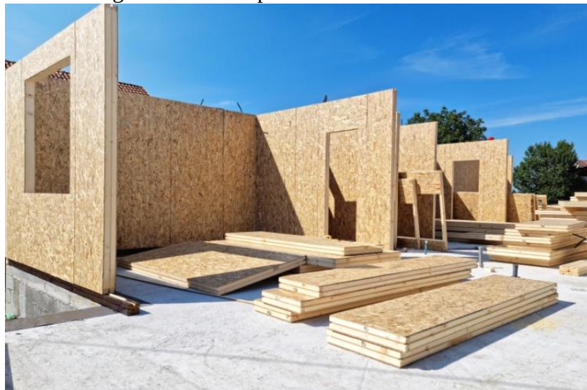
Figura 2 Obra limpa em Wood Frame
