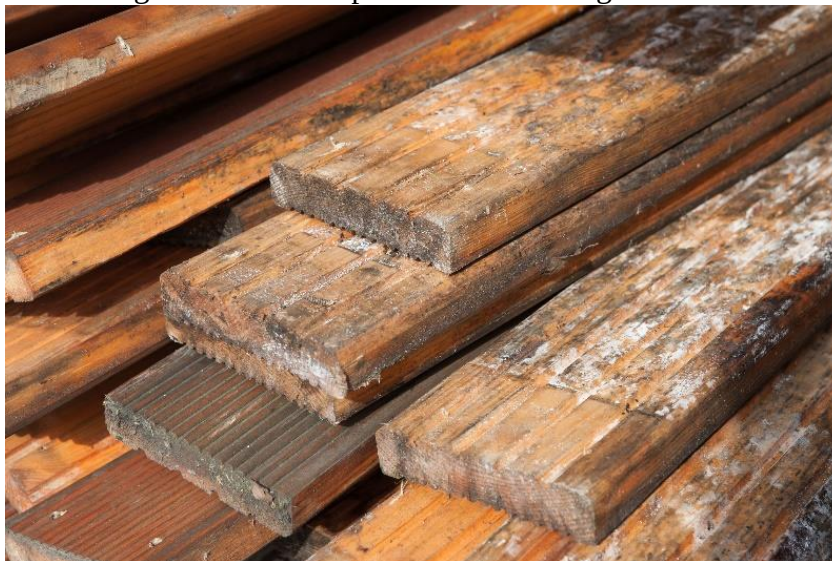
Figura 3 Madeira apresentando Patologias
