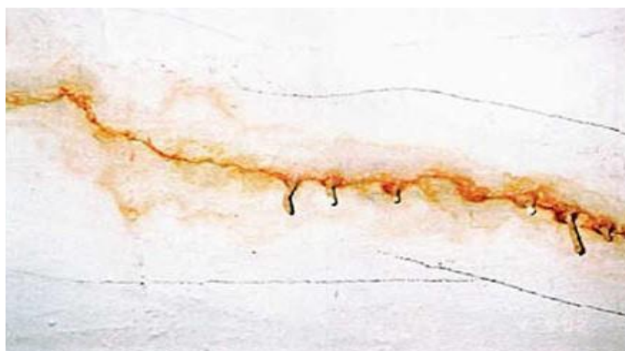
Figura 5 - Processo de carbonatação do concreto
