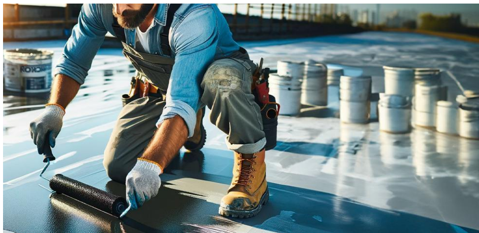
Figura 2 - Processo de aplicação da membrana acrílica
