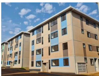
Figura 1 Construção em Wood Frame
