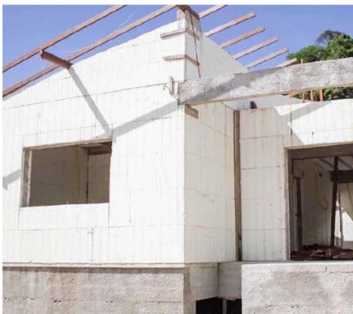
Figura 14 – Estrutura de cobertura montada
