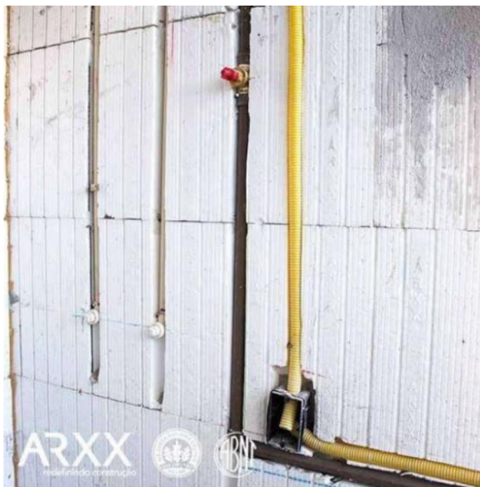
Figura 12 – Corte para instalação elétrica e hidráulica
