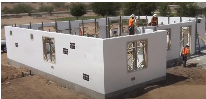
Figura 10 – Paredes esquadrejadas prontas para concretagem
