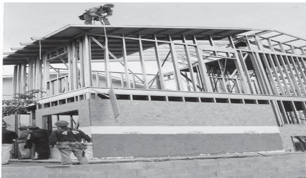
Figura 3 – Instalação de placas sobre o telhado
