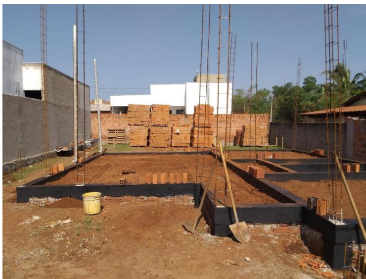
Figura 2: Utilização de tinta asfáltica impermeável
