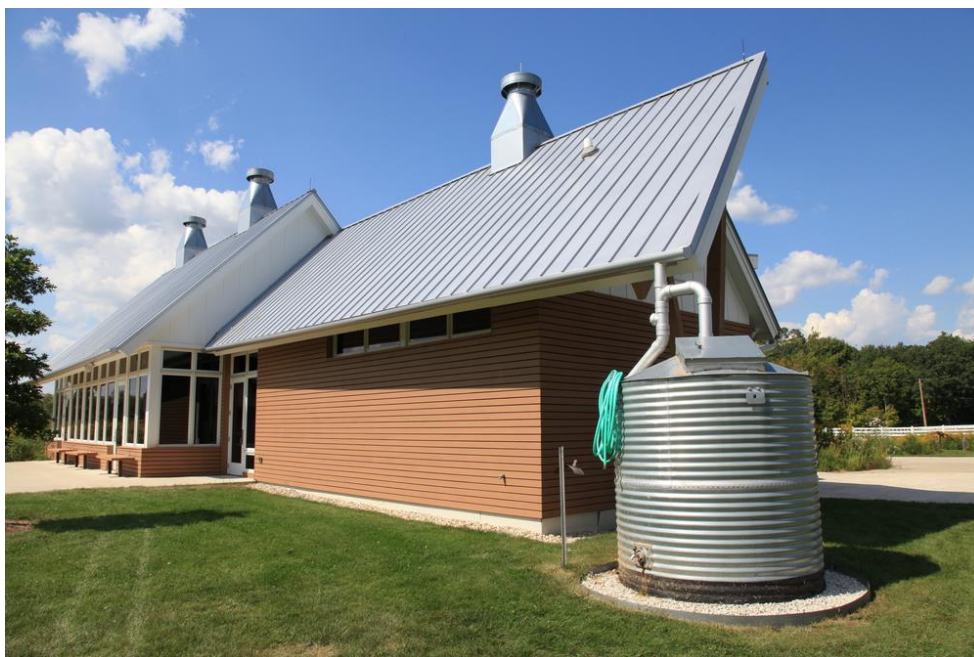
Figura 04: Cisterna de Aço
