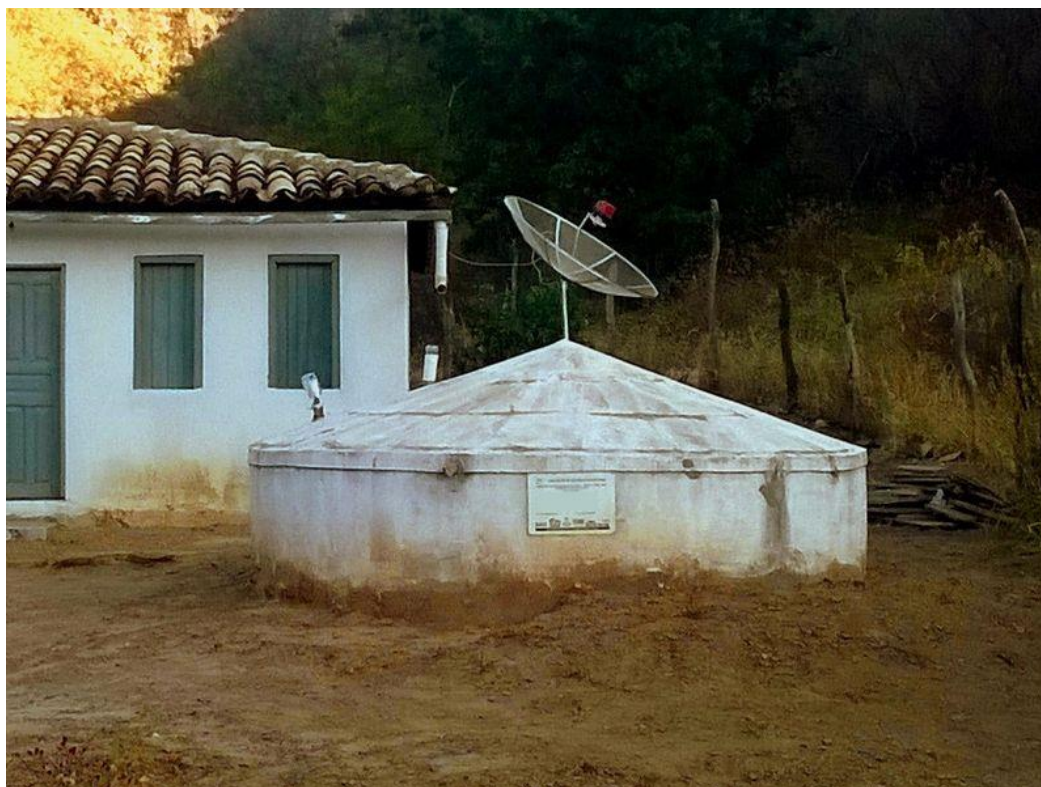
Figura 03: Cisterna de Placa
