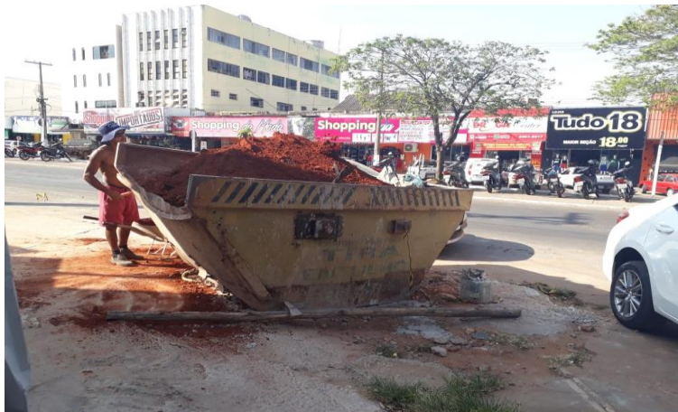
Foto 3: Caçamba com solo proveniente de escavação em Jaciara
