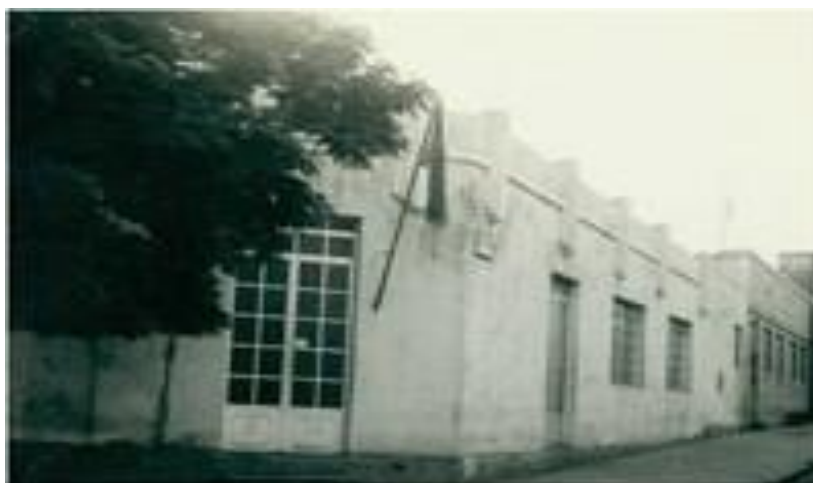
Primeiro prédio da Câmara Municipal 20
